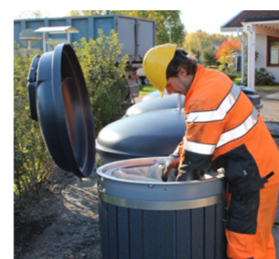
Joonis 3.8 Enne tõstekoti konteinerisse asetamist avage tõstekott ja keerake see sirgeks.
