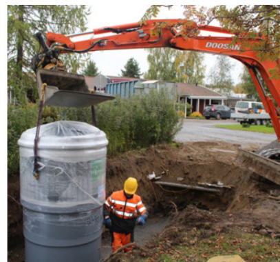
Joonis 3.3. Tõstke konteiner tõstekettide abil paigaldussüvendisse. Veenduge, et konteiner on sirgelt ja loodis.
