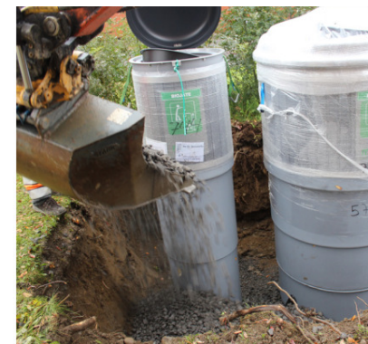
Joonis 3.4. Täitke paigaldussüvend 16-32 mm killustiku, ballastmaterjali ja sobiva viimistlusmaterjaliga.
