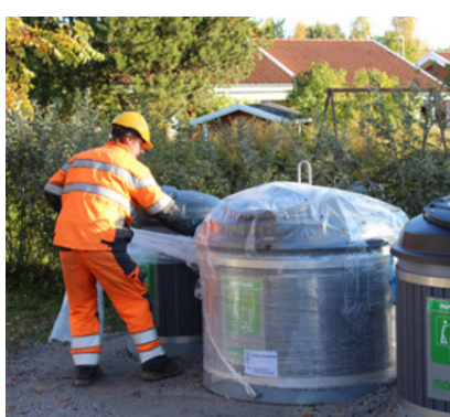
Joonis 3.6. Eemaldage plastkatted.
