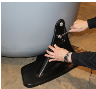
Joonis 3.2. Kinnitage plastist põhjankrud kahe poldi abil mahuti külge.
