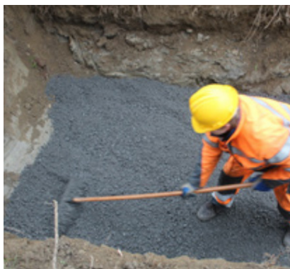
Joonis 3.1. Tasandamiseks võib kasutada 50 mm paksust 0-16 mm killustiku kihti.
