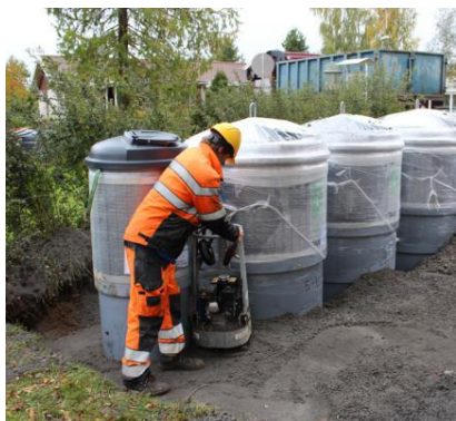
Joonis 3.5. Seejärel asetage killustiku peale ballastmaterjal (ankurdamine).
